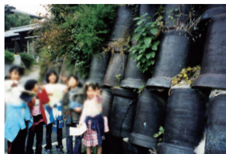
発生材による擁壁（愛知県の常滑焼）
